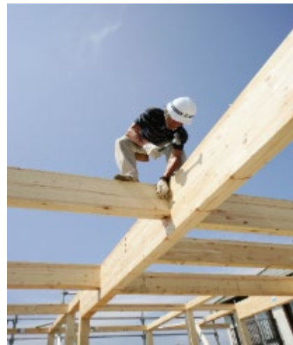
梁組金物打込み施工状況
