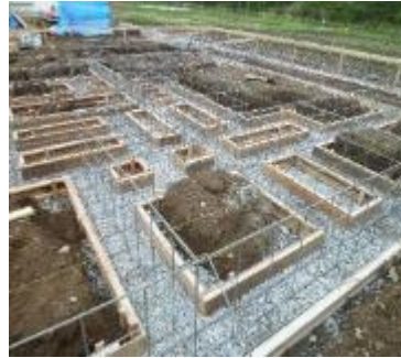
鉄筋配筋・型枠設置状況
