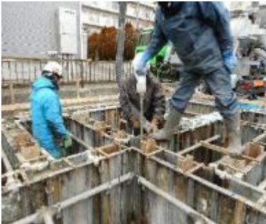
コンクリートバイブレーター状況
