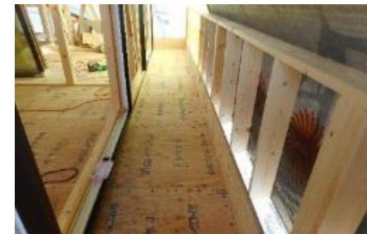
筋外と金物施工状況
