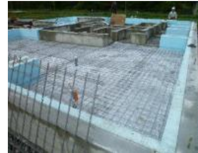
防湿フィルム設置状況
