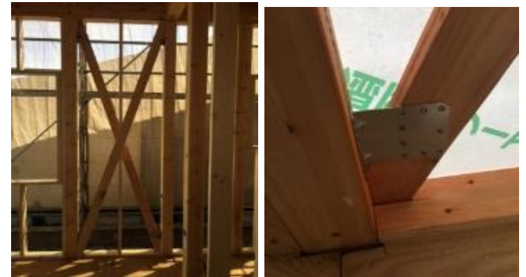
筋外と金物施工状況
