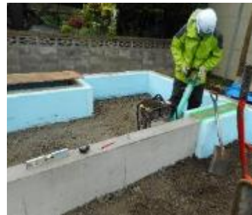
内部碎石転圧状況
