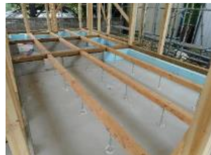
床下地組状況
