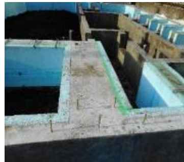
アンカーボルト設置状況
