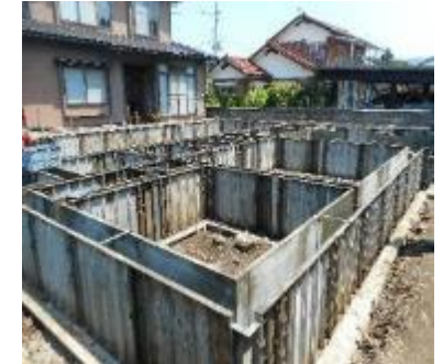
鋼製枠設置助教
