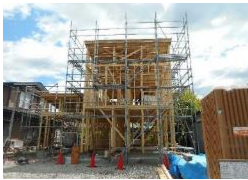
軸組組立状況
