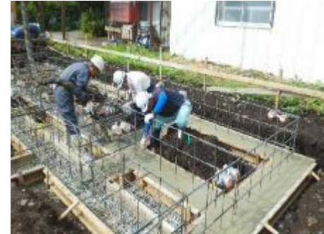
ベース生コン打ち状況
